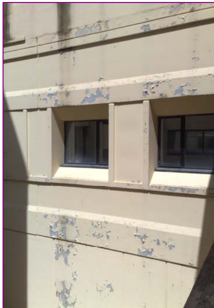
Uno dei muri esterni della sede di Santa Palomba
